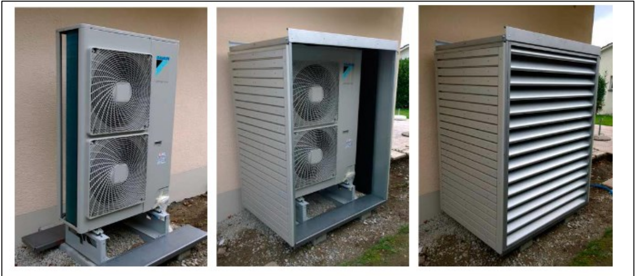
FIGURE 43: EXEMPLE DE FICHE TECHNIQUE D'UN CAISSON ACOUSTIQUE
